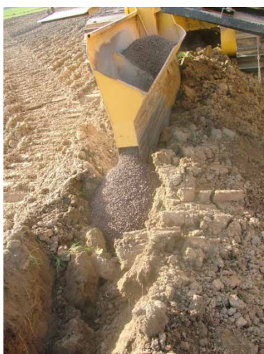
Figur 2. Modern täckdikningsteknik innebär att dräneringsrör av plast kan läggas med grusfilter kring ledningen och filter mellan markytan och dräneringsledningen utan grävning av öppet schakt. (Foto:C-J Rangsjö)
