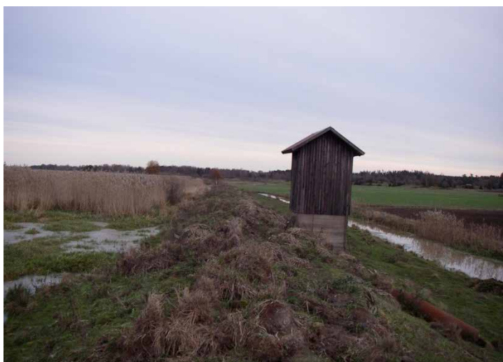
Figur 5. Invallning med vall, pumpstation, valldike och invallningsområde med åkermark. (Foto: C-J Rangsjö)
