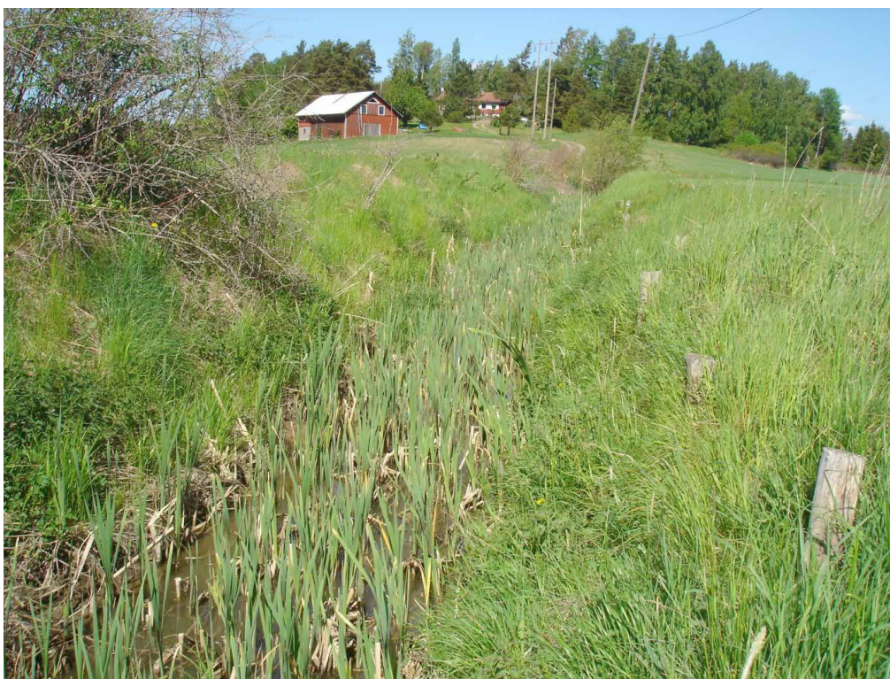
Figur 18. Sommartid ökar friktionen i diket på grund av växtligheten vilket orsakar höga vattennivåer. (foto:C-J Rangsjö)
