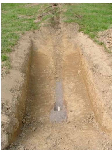
Figur 2. Modern täckdikningsteknik innebär att dräneringsrör av plast kan läggas med grusfilter kring ledningen och filter mellan markytan och dräneringsledningen utan grävning av öppet schakt. (Foto:C-J Rangsjö)
