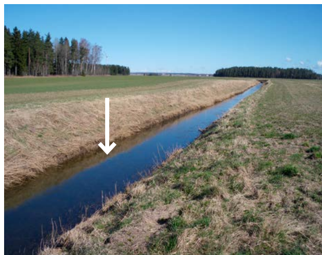
Diket är dimensionerat så att vattenytan inte ska stiga för högt under vegetationsperioden och skada växternas rötter (foto Anuschka Heeb).
