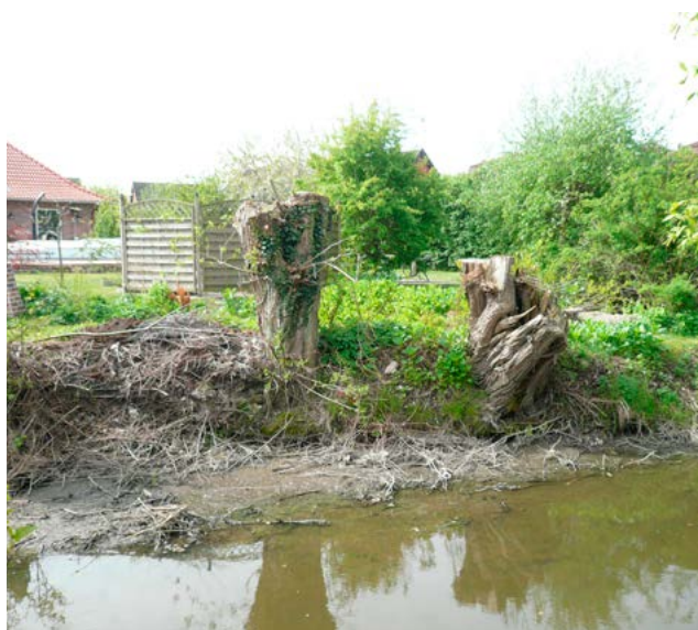
Det är viktigt att vara rädd om slänterna så de inte eroderar som här (foto Tilla Larsson).
