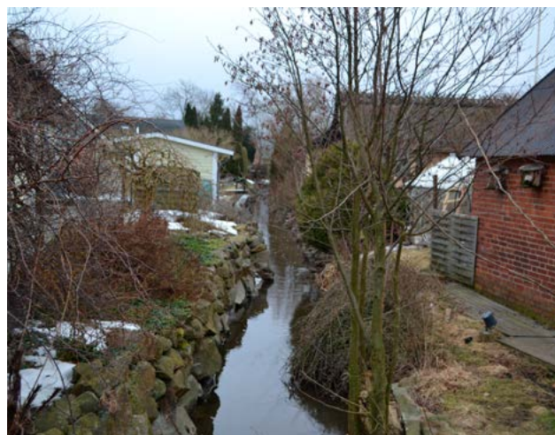
Här har bebyggelsen gjort det svårt att underhålla diket (foto Alva Agger).
