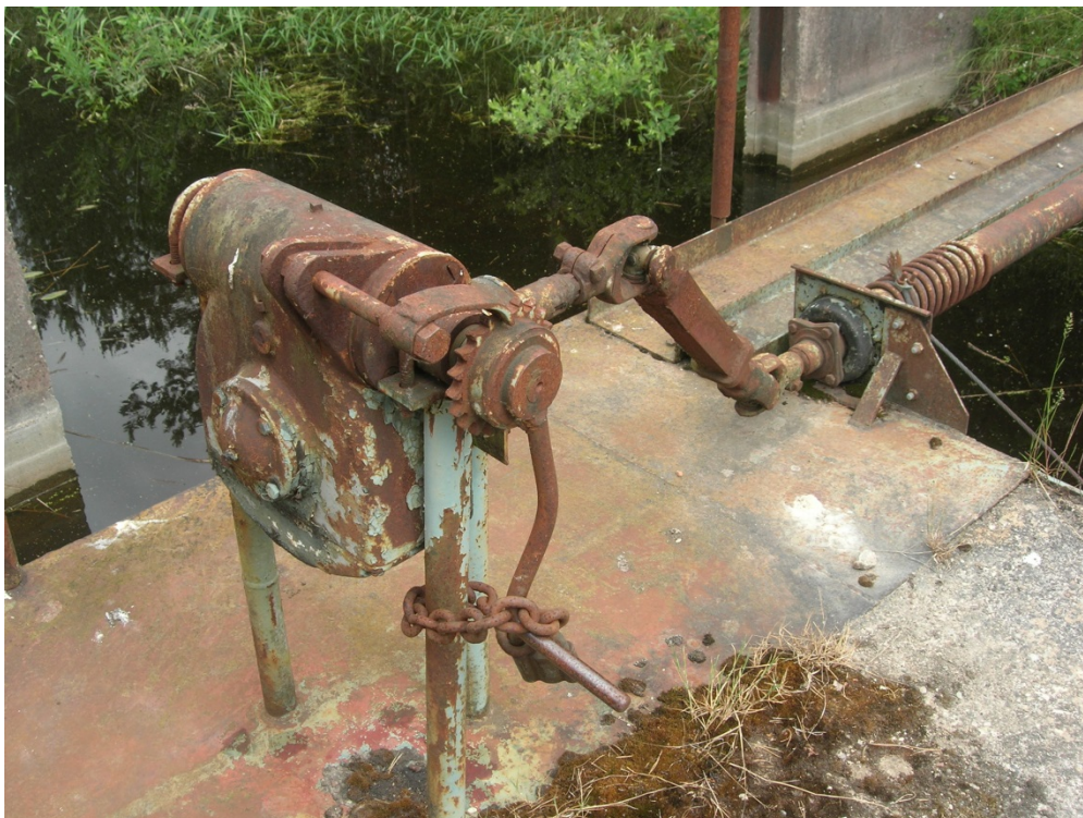
Detaljbild av exempel på växel med vev som används för att fälla upp luckan. Vevan är fastlåst för att förhindra att annan än luckskötaren reglerar luckan. Storemyrs vattenavledningsföretag år 1975.
